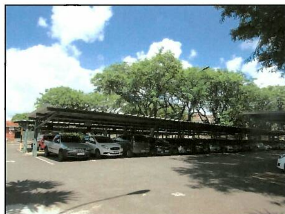
Foto 4 Vista geral do estacionamento.
