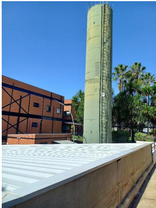
Figura 2 - Localização atual do reservatório
