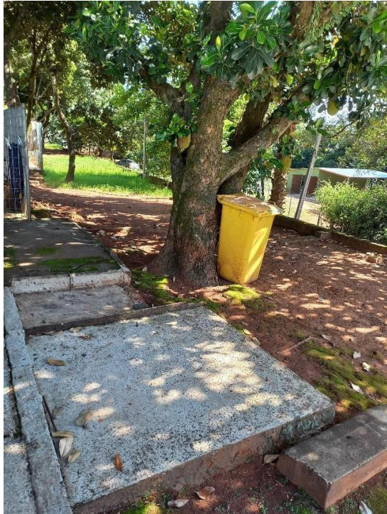
Figura 1 - Base de concreto existente a ser removida
